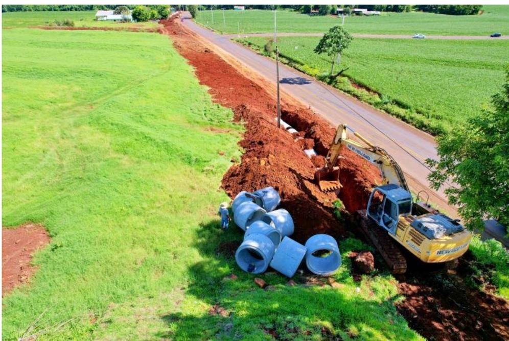
Figura 09: Obra de drenagem na PR 497, disponível em: <http://www.itaipulandia.pr.gov.br/noticia/2987/implantacao-de-galerias-pluviais-na-pr-497-trara-solucao-para-o-escoamento-das-aguas-das-chuvas>
